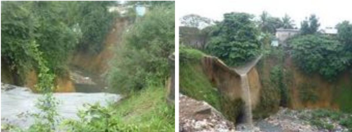
**Yopougon Koweit. Erosion en aval d'un réseau en béton**
