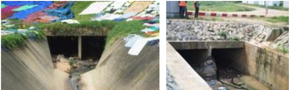
La transition entre la section trapézoïdale amont et le cadre de passage du pont devra être progressive (angle inférieur à  $8^\circ$ ) afin d'éviter le décollement de la couche limite de l'écoulement et l'augmentation sensible des pertes de charges singulière
