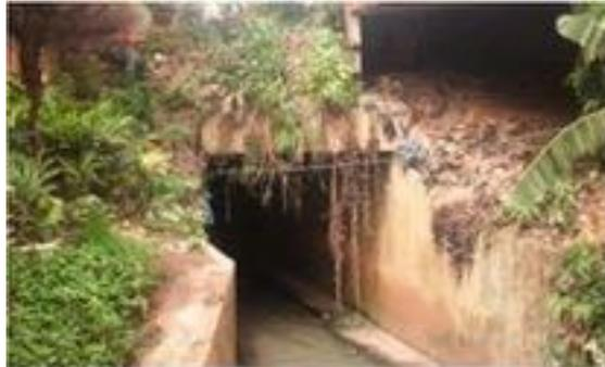
Figure 1 Exemple de restriction forcée de la section d'écoulement
